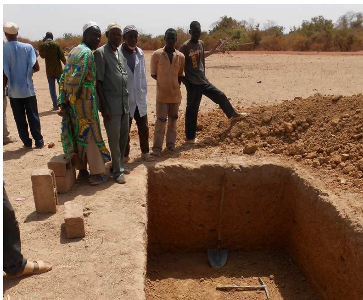
Bau der Toiletten wird vorbereitet
