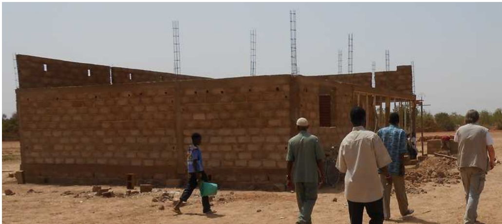
Rohbau des Nähateliers in Kassan
